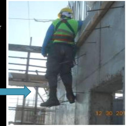
A WORKER DOING THE LINTEL BEAM FORMWORK WAS USING THE WINDOW SILL AS A WORKING PLATFORM
